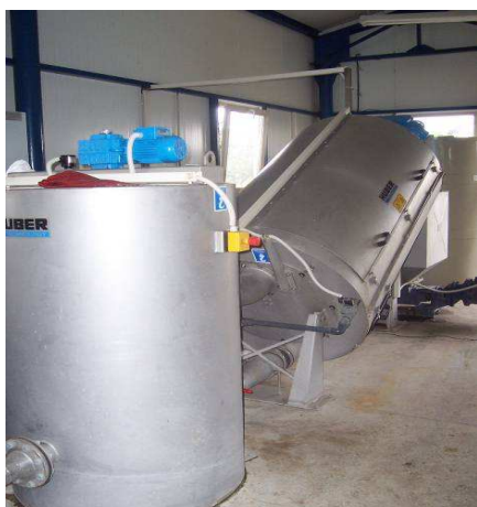
Figura Nr. 2-18 – Instalație de deshidratare a nămolului
