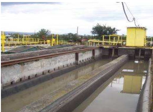
Figura Nr. 2-11 – Deznisipator
