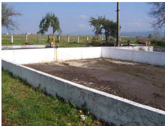
Figura Nr. 2-36 – Platforme de uscare nămol
