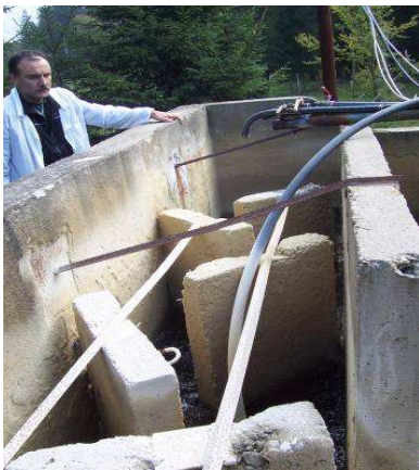
Figura Nr. 2-31 – Camera de amestec
