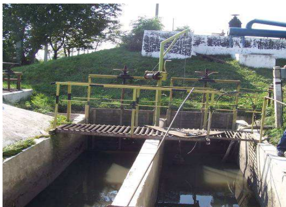
Figura Nr. 2-27 – Deznisipator
