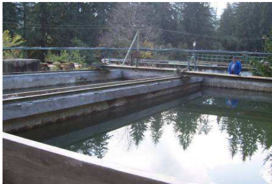
Figura Nr. 2-33 – Decantor longitudinal
