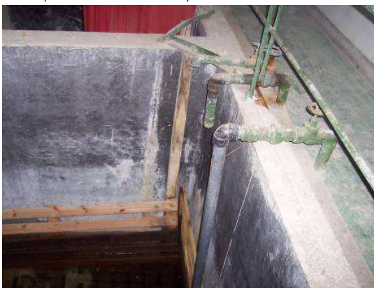
Figura Nr. 2-32 – Camera de preparare a polielectrolitului
