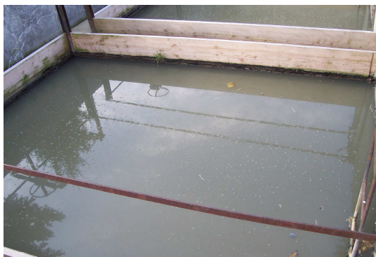
Figura Nr. 2-43 – Separator de grăsimi
