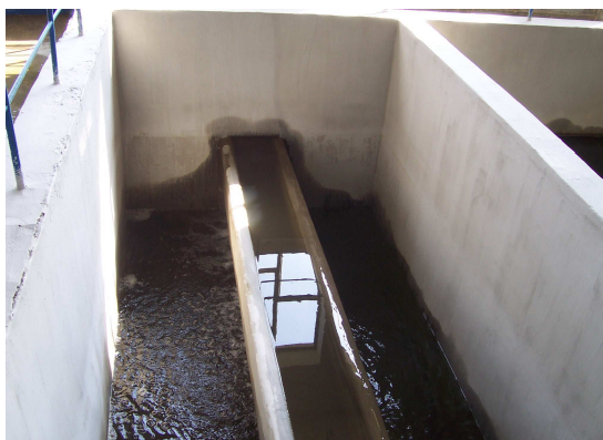
Figura Nr. 2-39 – Filtru
