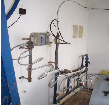
Figura Nr. 2-8 – Stație de clorinare
