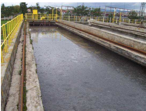
Figura Nr. 2-11 – Deznisipator
