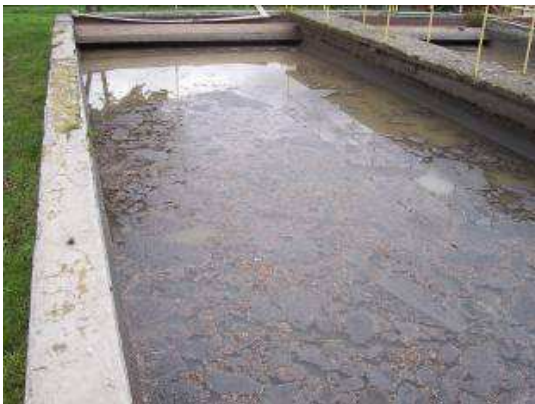
Figura Nr. 2-13 – Decantor longitudinal primar
