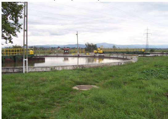
Figura Nr. 2-16 – Decantor secundar radial
