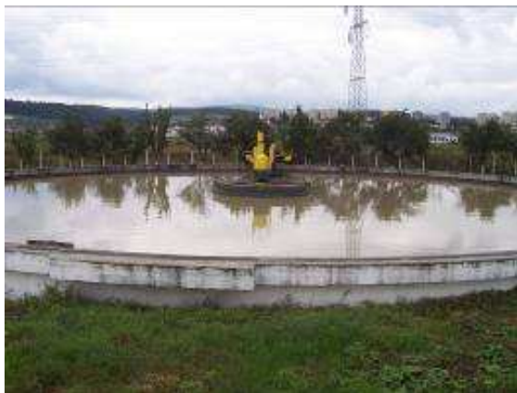
Figura Nr. 2-14 –Decantor radial primar
